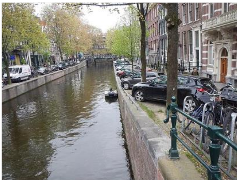
Figuur 4-5 – Voorbeeld uitbuiken van kademuur
