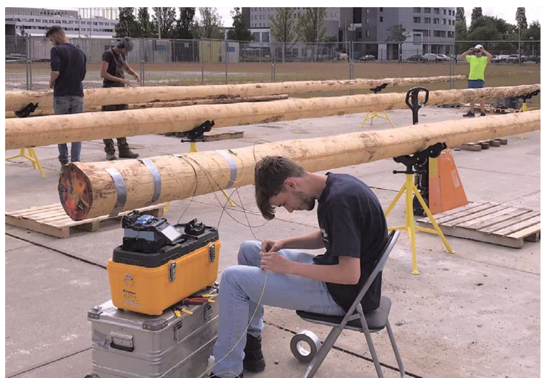
Figuur 2 – Aanbrengen van de glasvezelrekstroken in de palen.
